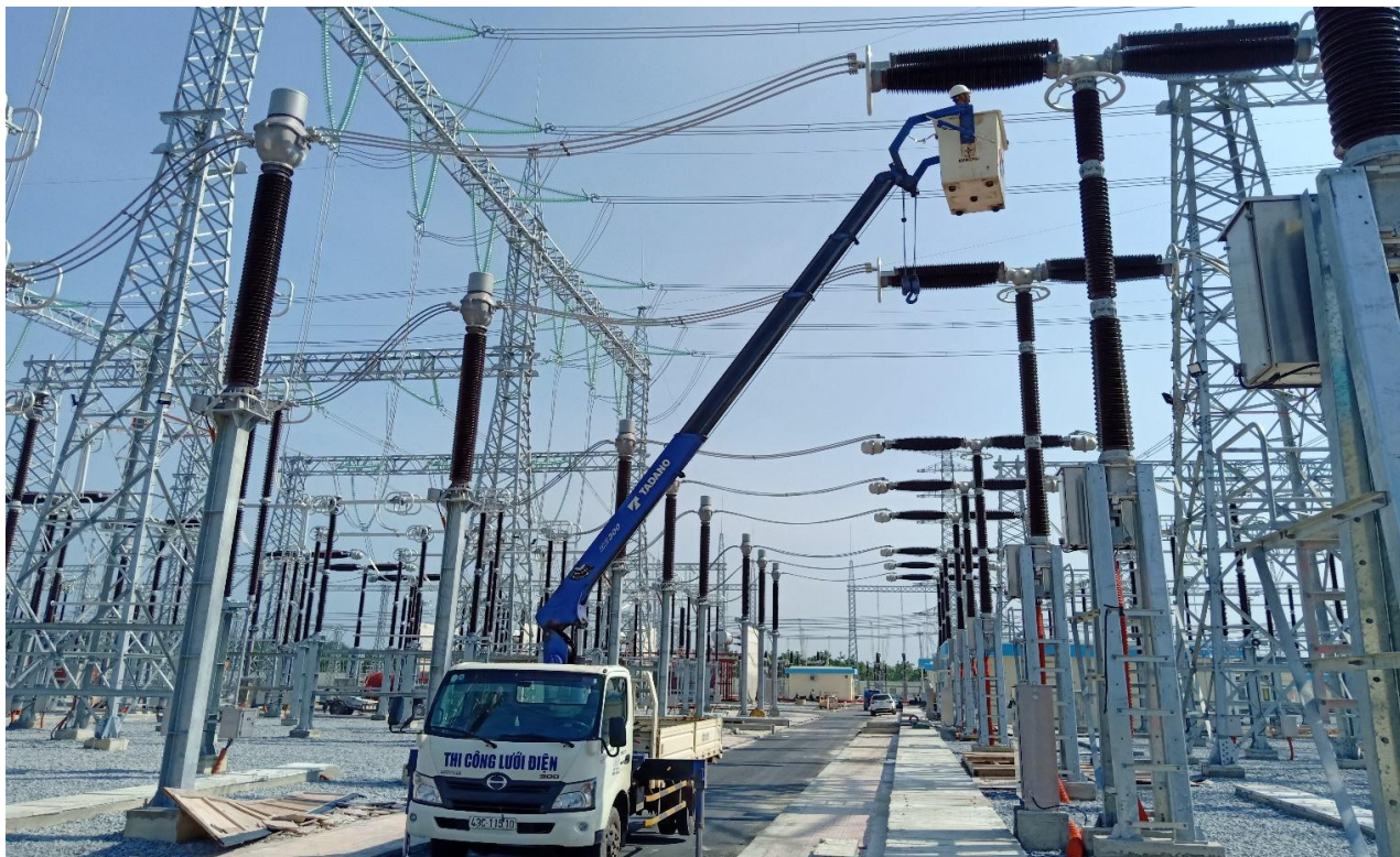
Thí nghiệm đưa vào vận hành TBA 500kV Chơn Thành (2020)
