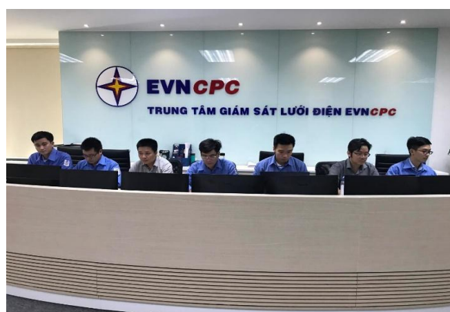
Thử nghiệm SCADA tại TTGS EVNCPC
