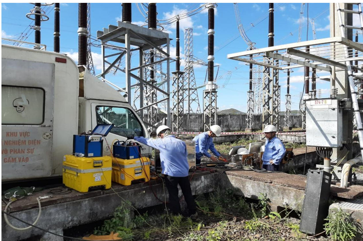
Đo thông số ĐZ 500kV - 2018
