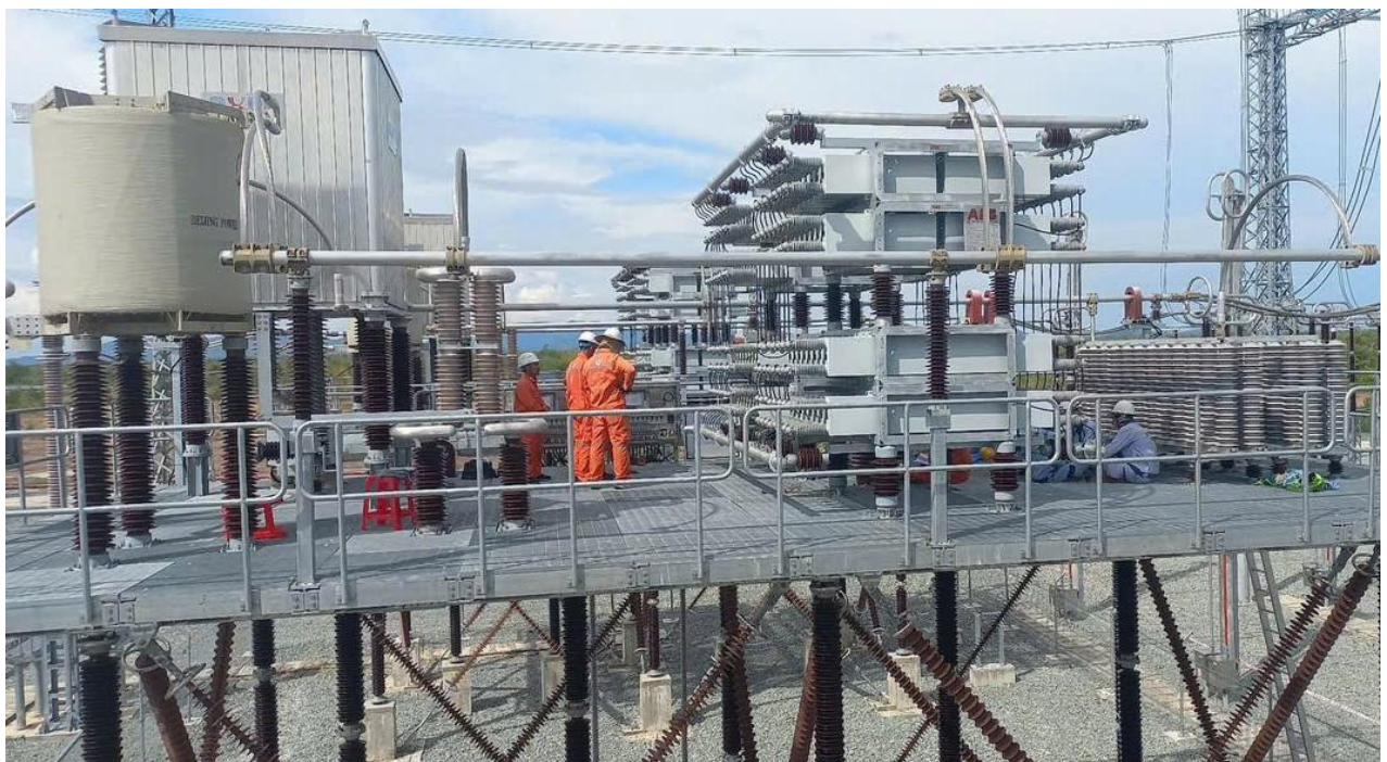
Thí nghiệm tại TBA 500kV Easoup - 2023
