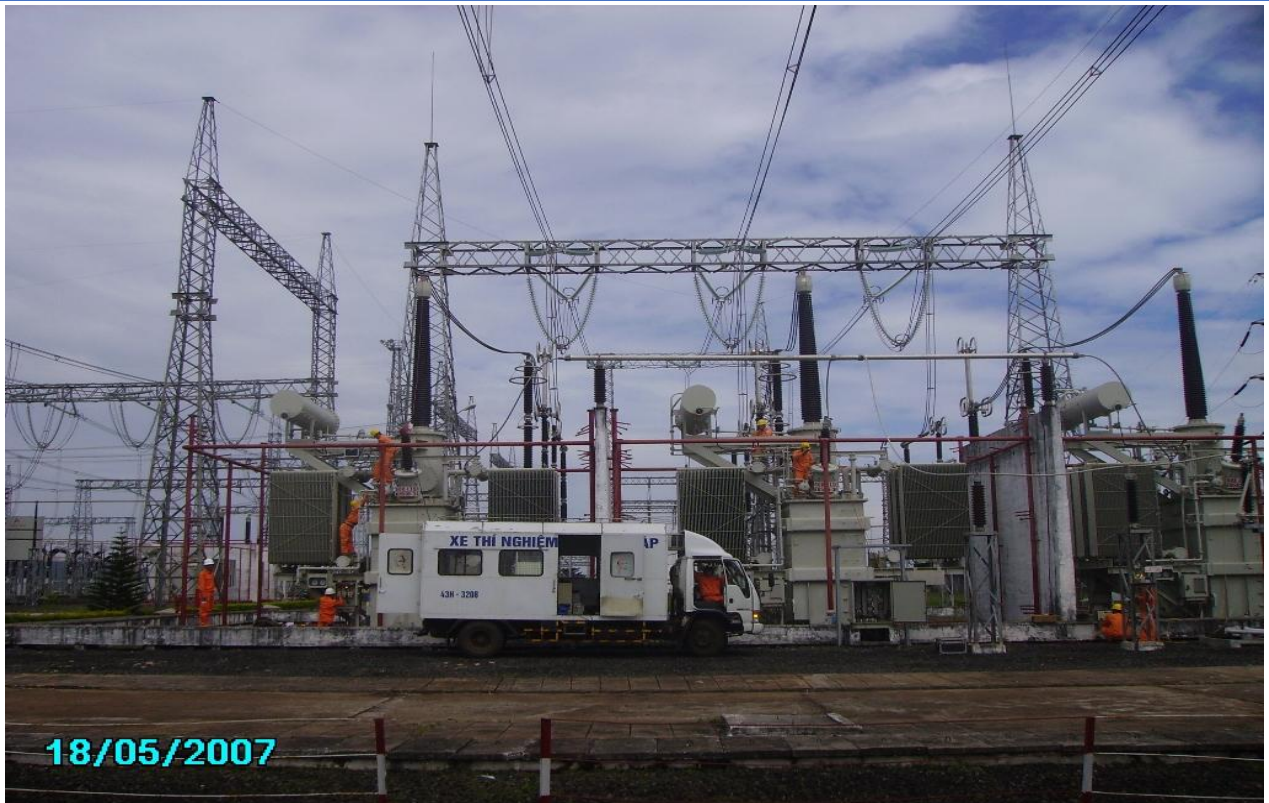
Thí nghiệm tại TBA 500kV Pleiku - 2007
