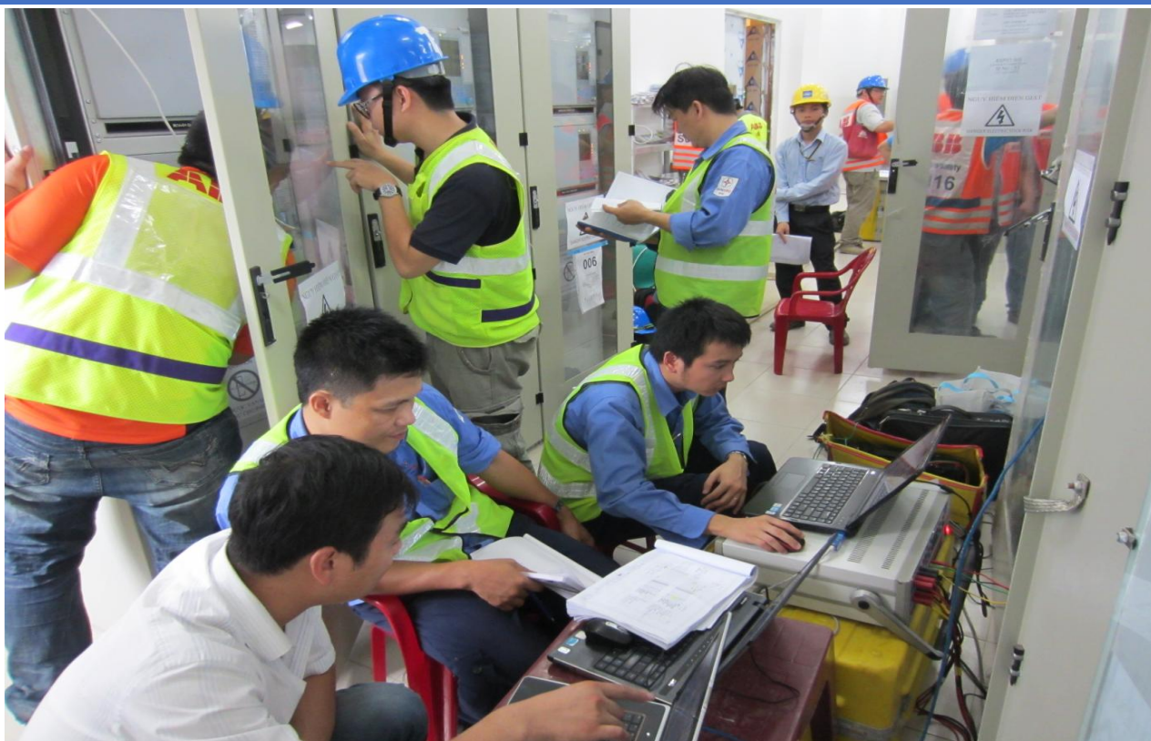
Thí nghiệm tại Gis 220kV- Nhà máy thép Formosa- Hà Tĩnh - 2014
